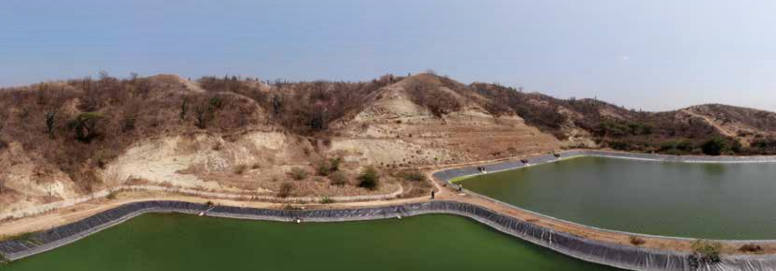
Laguna de tratamiento de aguas residuales. Pampas de Hospital, Tumbes.
