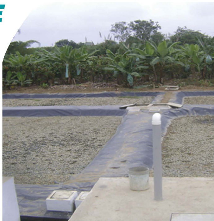
Laguna en construcción. El humedal se impermeabiliza para evitar pérdidas de agua.
